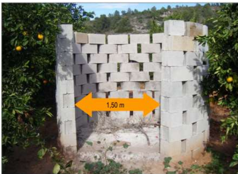
Imagen 2. Abertura lateral o boca de alimentación de un quemador agrícola. Fuente: Norma Técnica de Quemadores Agrícolas. Plan de Prevención de Incendios Forestales de la Demarcación de Crevillent.
