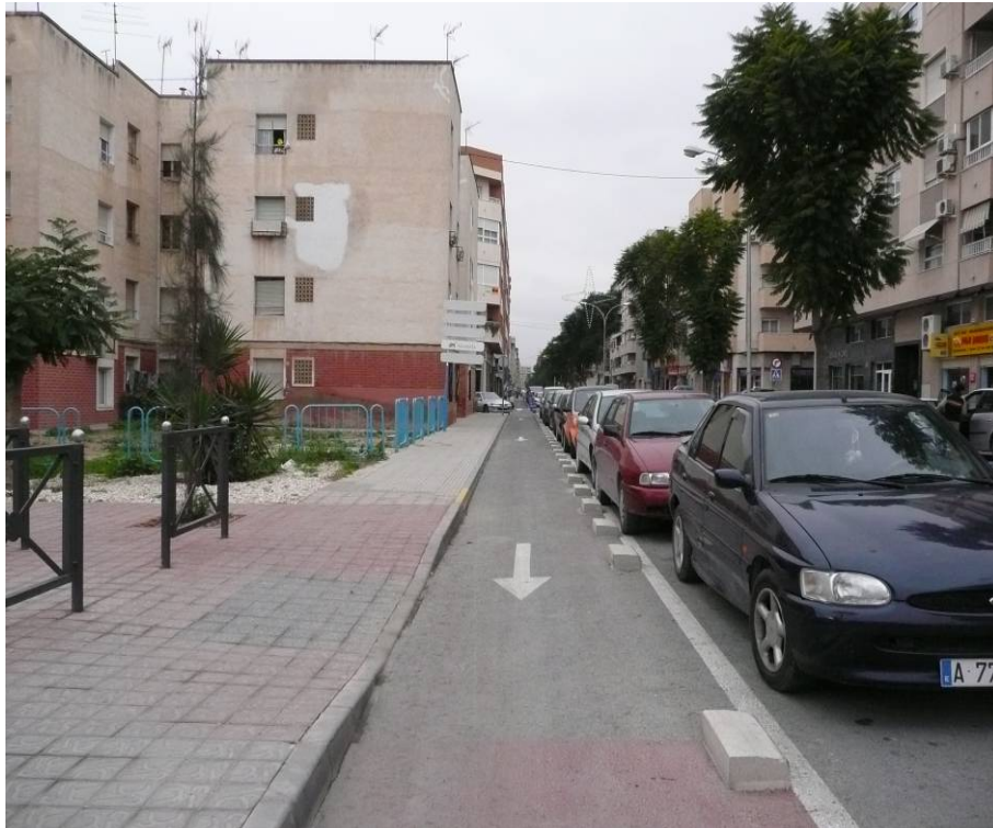
Fotografía 38: Antigua separación del carril-bici mediante bloques de hormigón.
