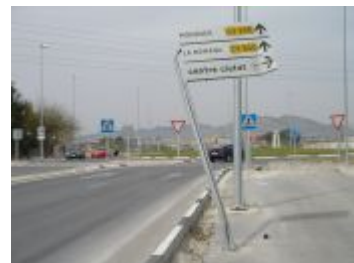
Señalización vertical pendiente de reposición en carreteras de la red autonómica dentro de Novelda.
