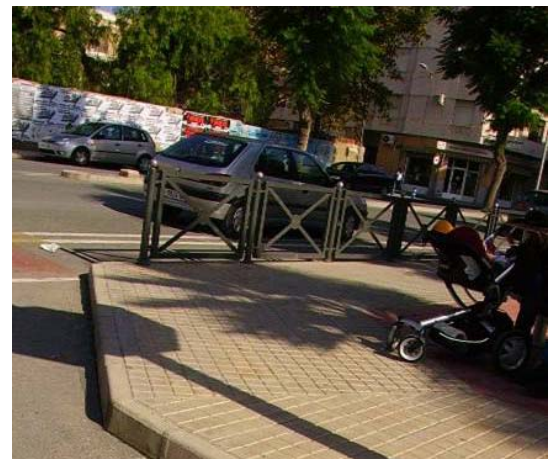
Imagen de la falta de una rampa en un paso de peatones.
