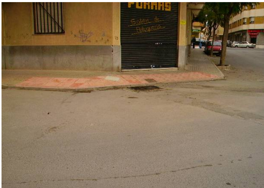
Fotografía 30: Falta de orejetas en esquina de edificio.
