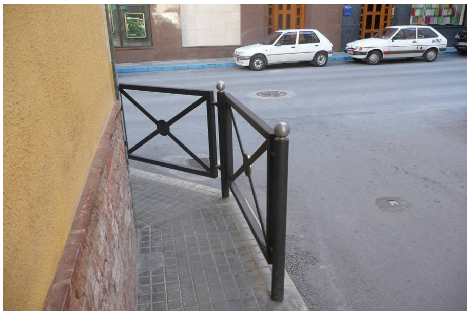
Fotografía 33: Acera de una calle del centro de Novelda. El ancho es insuficiente.
